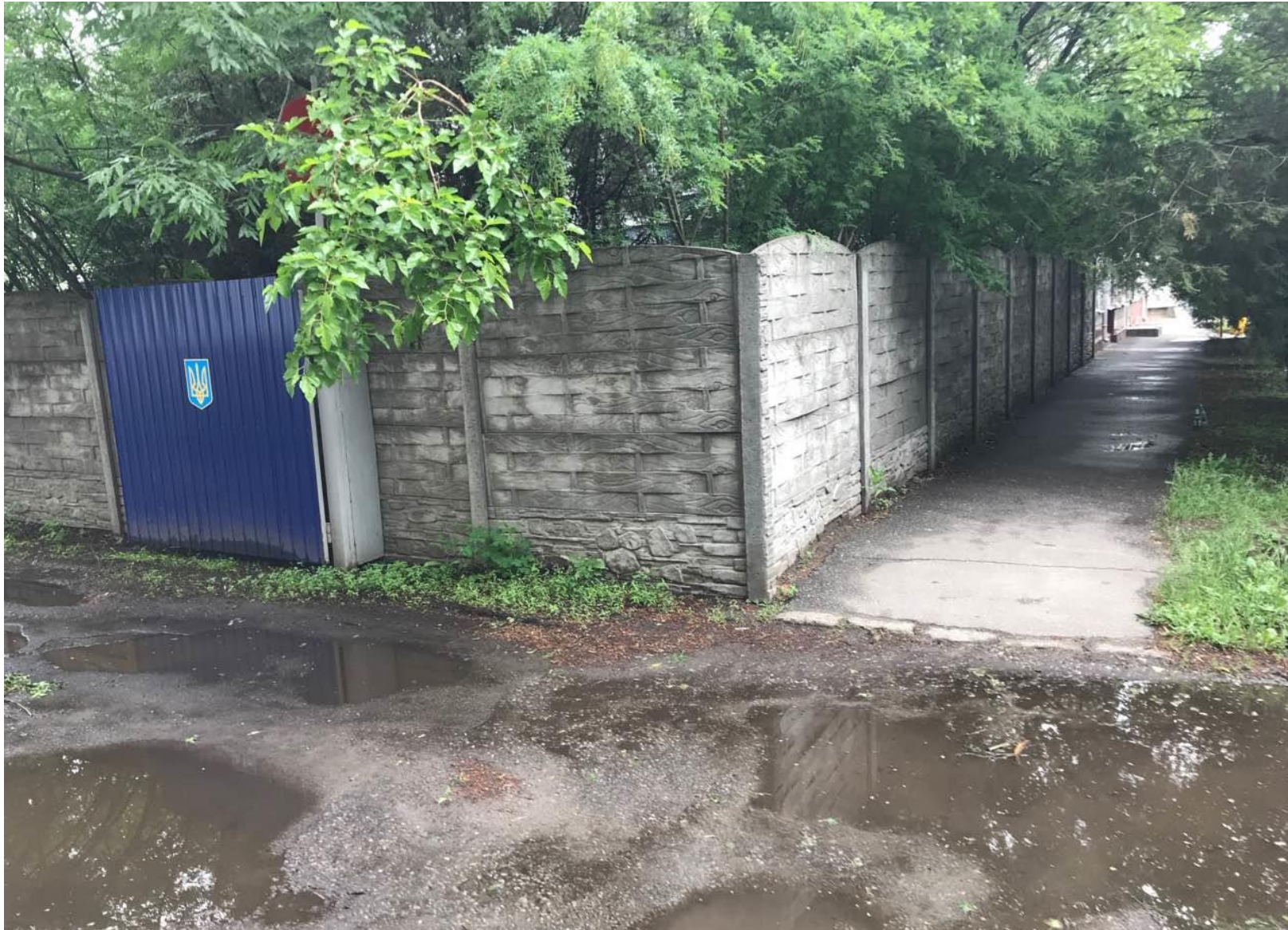
Фото 23 Прилегла територія Кременчуцького районного суду Полтавської області Вид 1 (В'їзд до подвір'я суду - альтернативного входу)
